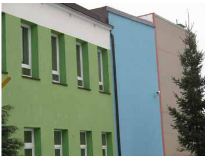
Remont Miejskiego Przedszkola Nr 4
