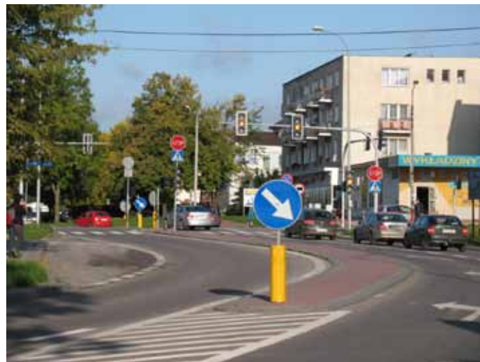
Przebudowa Centrum, skrzyżowanie ul. Białostockiej i ul. Piłsudskiego
