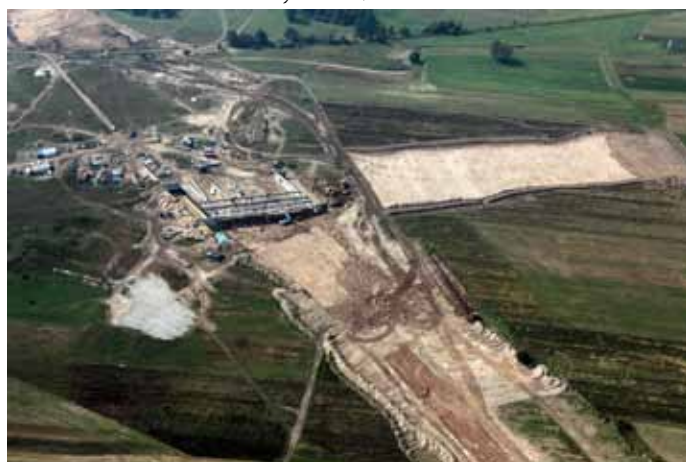
Budowa obwodnicy Zambrowa i Wiśniewa z lotu ptaka
