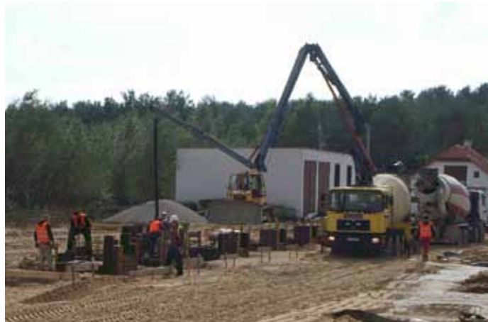
Budowa Zakładu Przetwarzania i Unieszkodliwiania Odpadów w Czerwonym Borze
