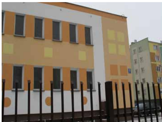
Remont Miejskiego Przedszkola Nr 6
