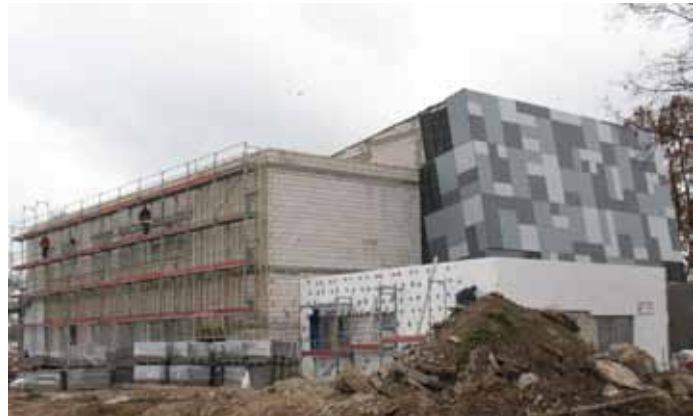
Budowa Centrum Kultury w Zambrowie
