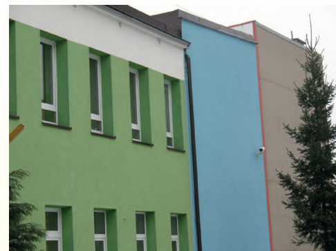
Remont Miejskiego Przedszkola Nr 4
