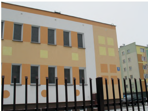
Remont Przedszkola Nr 6
