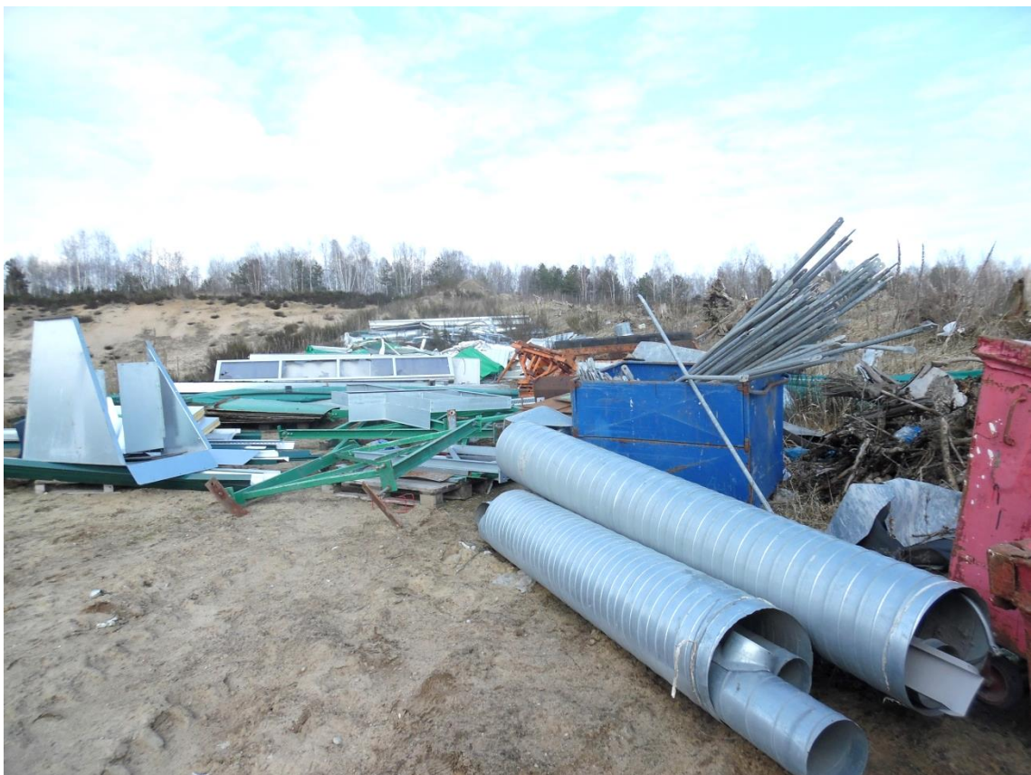
12. Zdemontowane elementy instalacji wentylacji (kanały wentylacyjne) z linii sortowniczej oraz inne elementy konstrukcji i wyposażenia obiektów
