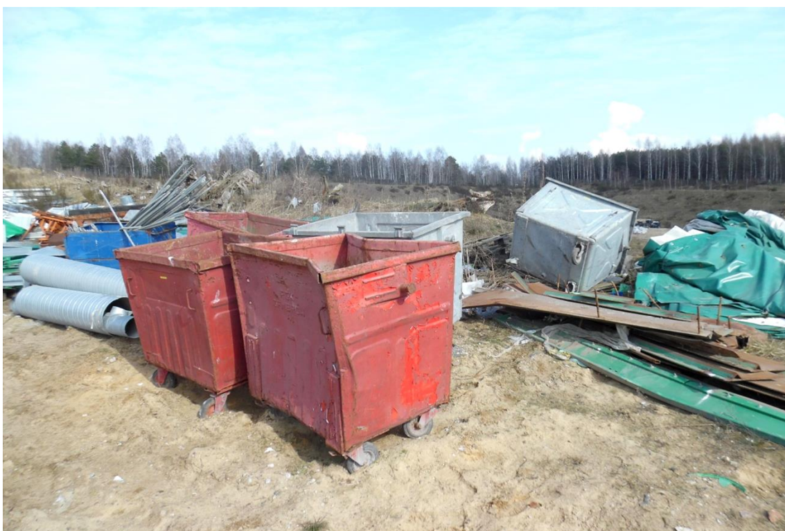
16. Pojemniki metalowe na odpady (malowane i ocynkowane) – 5 szt., elementy instalacji wentylacji i inne elementy konstrukcji obiektów
