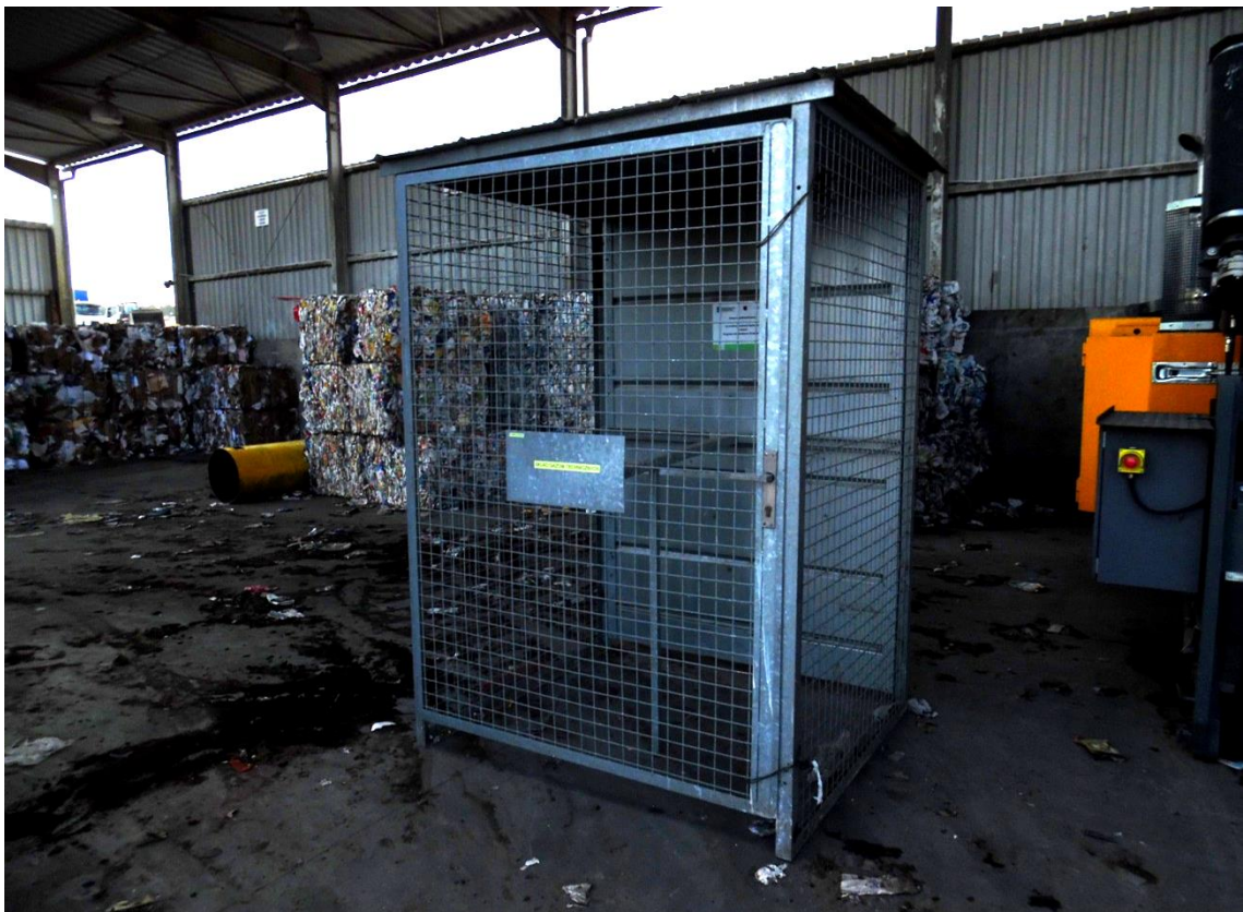
7. Magazyn gazów technicznych (stojak metalowy), brak tabl. znamionowej
