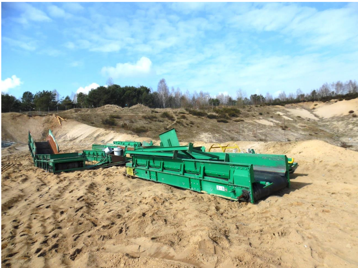
11. Zdemontowane przenośniki taśmowe z linii sortowniczej – 3 szt.
