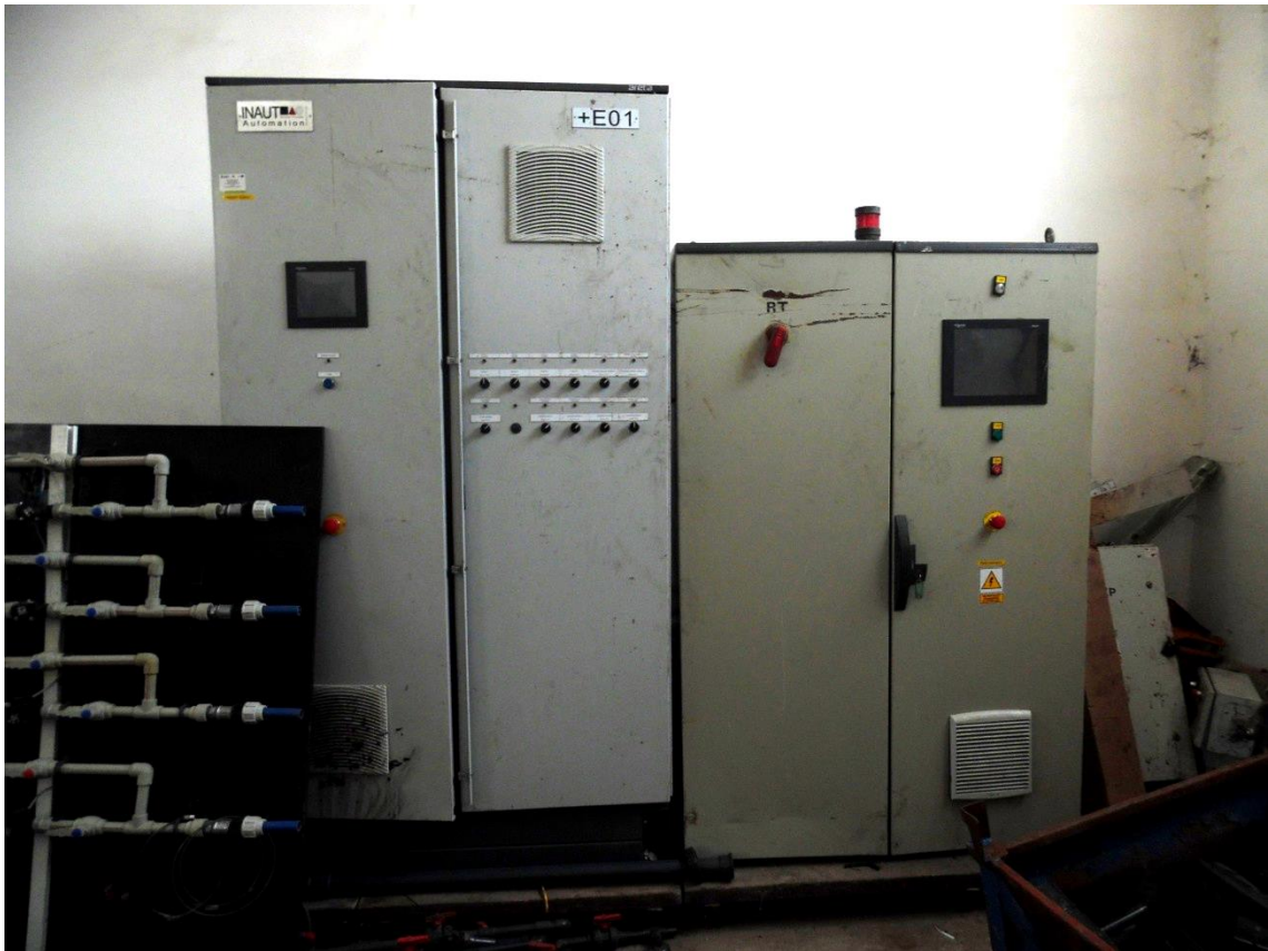
9. Szafa sterownicza linii sortowniczej LSz43/R3BW 295/7 i szafa sterownicza modułów kompostujących
