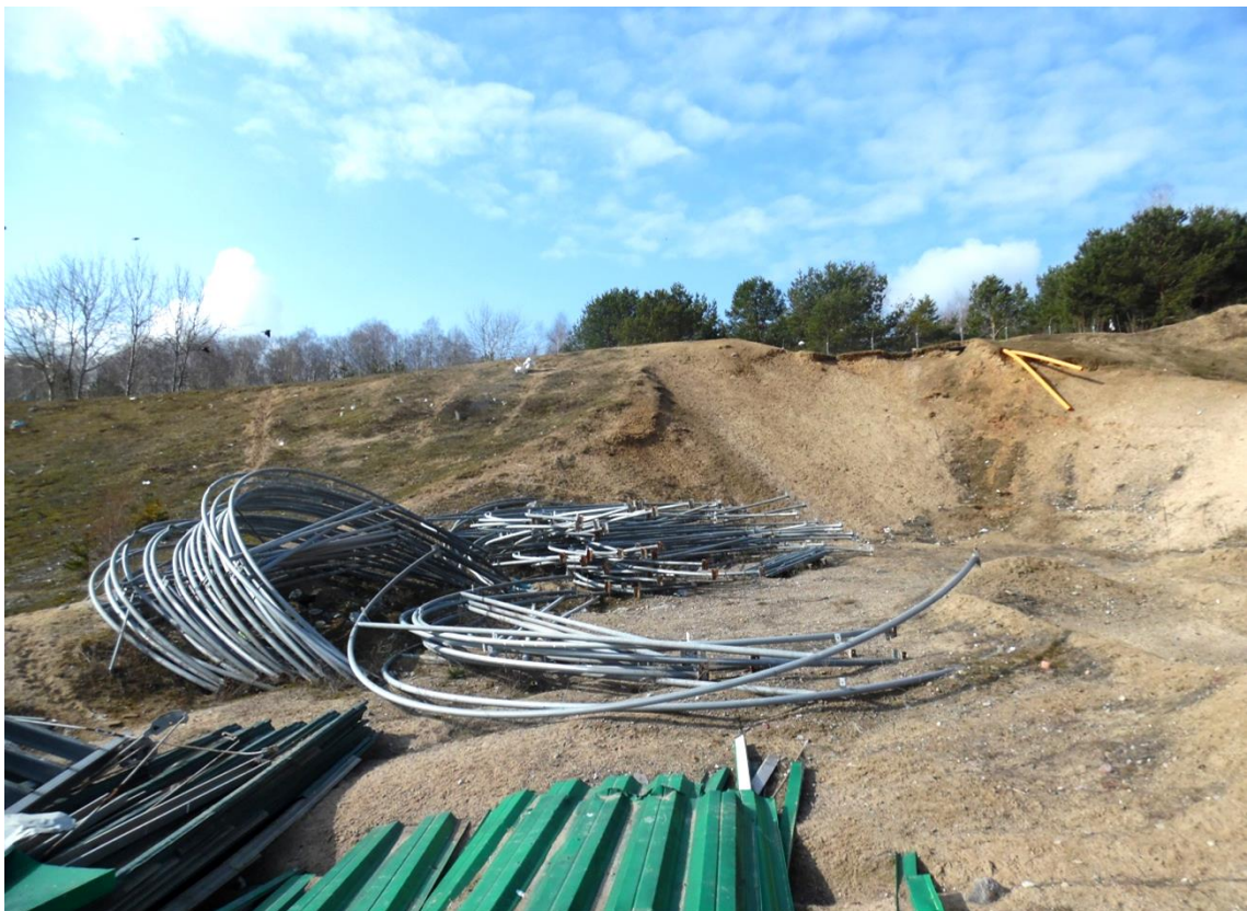
13. Konstrukcja nośna pokrycia dachowego reaktorów procesowych oraz elementy konstrukcji i blachy z obudowy i dachu budynku nadawy sortowni
