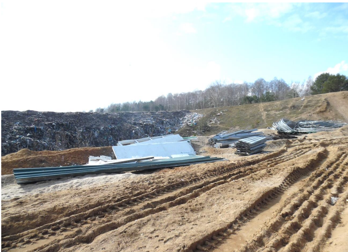
14. Elementy konstrukcji i blachy ze ścian i dachu budynku nadawy sortowni, elementy bram wjazdowych (segmentowych) z PCV i konstrukcja nośna pokrycia dachowego reaktorów procesowych
