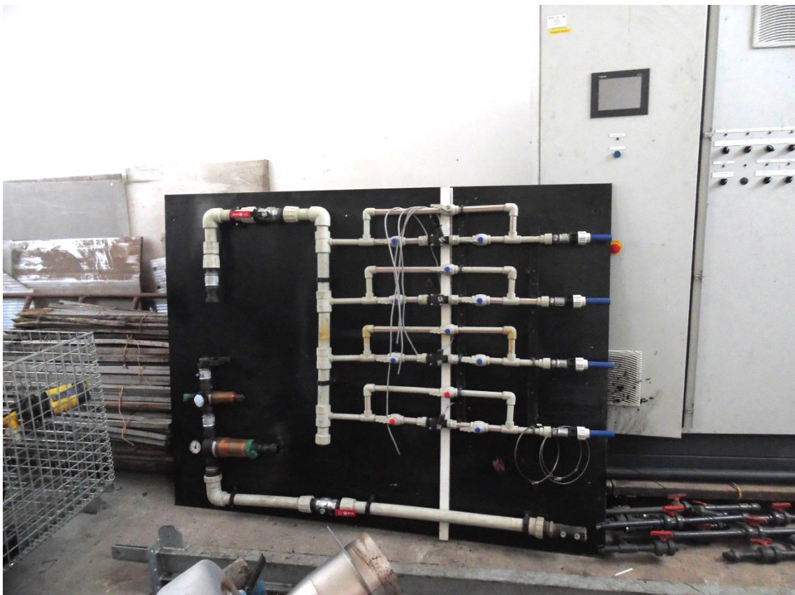
10. Panel zraszania kompostowni odpadów organicznych
