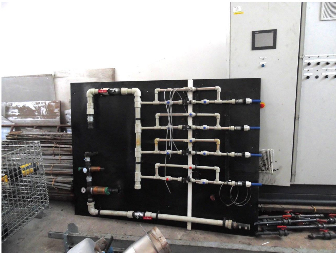
7. Panel zraszania kompostowni odpadów organicznych
